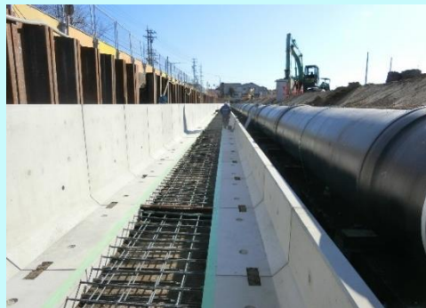
農業用水路の整備
