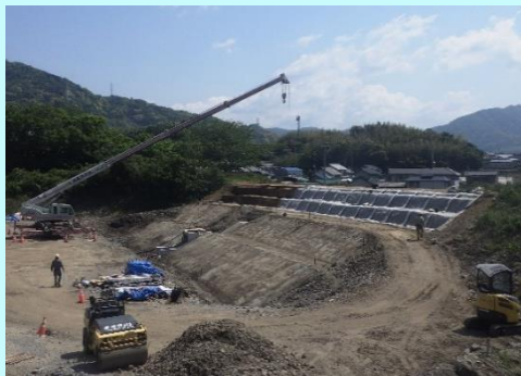
農業用ため池の整備
