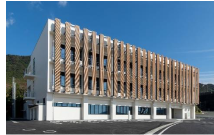
「農林業の知と技の拠点」本館 (山口県農林総合技術センター) (山口県防府市牟礼10318)
