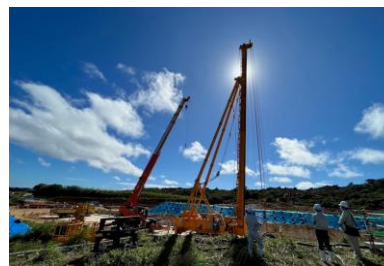
▲地下ダム建設（宮古島）
