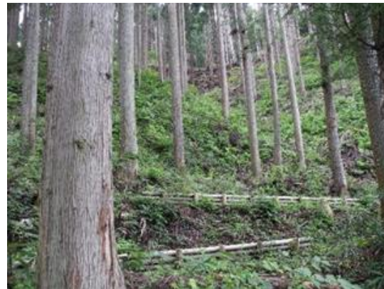
放射性物質対策と一体となった 森林整備（須賀川市）
