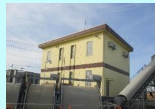
排水機場の耐震対策・更新整備
