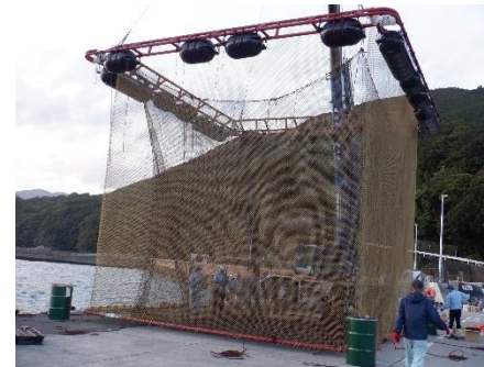
組立て作業中の 浮沈式いけす
