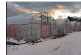
地熱発電所の熱水を利用しているハウス
