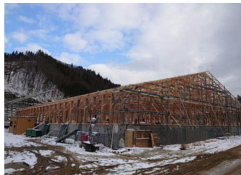
秋田スギを使用したトラス工法による畜舎
