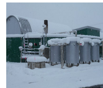
脱硫施設と発酵槽
