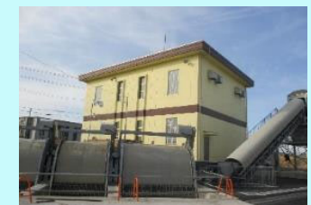
排水機場の耐震対策・更新整備
