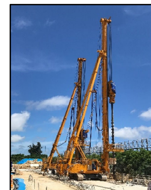
【宮古島における 地下ダムの施工状況】
