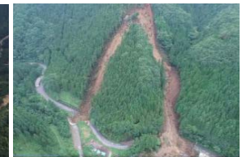
国有林の被害状況(兵庫署) 【東山国有林(兵庫県宍粟市)】
