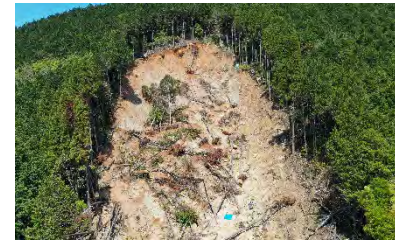
工事着手前（令和3年4月）
