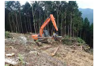
樹木採取区内での伐採作業
