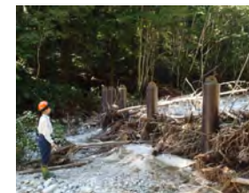
独立基礎型流木捕捉工
