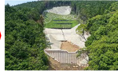
工事完了（令和4年5月）
