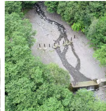
独立基礎型流木捕捉工
