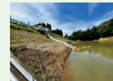
排水ポンプ車による被災ため池の低水位管理
