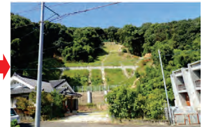
現況(令和5年9月)
