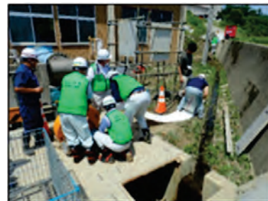
【MAFF-SATによるポンプ設置作業】
