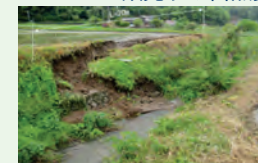
地震による農地法面の崩壊
