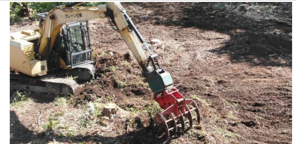
大型機械による地拵え
