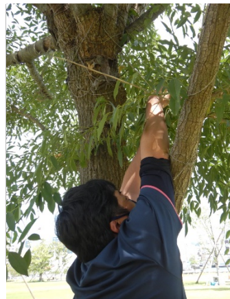
テックス板の設置作業
