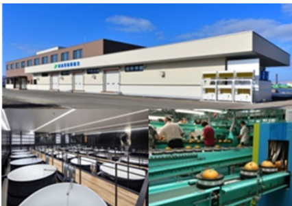
集出荷・貯蔵・加工施設
