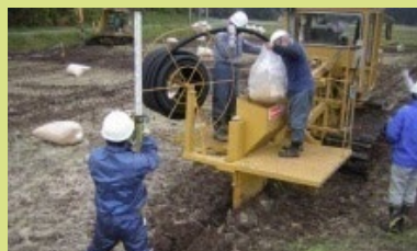
③ 暗渠排水
