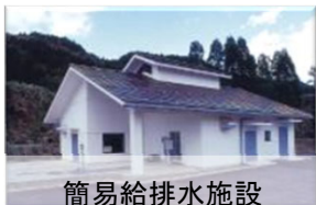
簡易給排水施設
