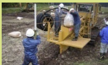
③ 暗渠排水
