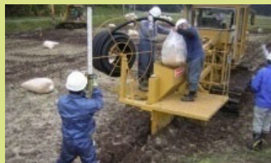
③ 暗渠排水
