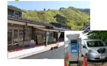
EV車等への給電設備
