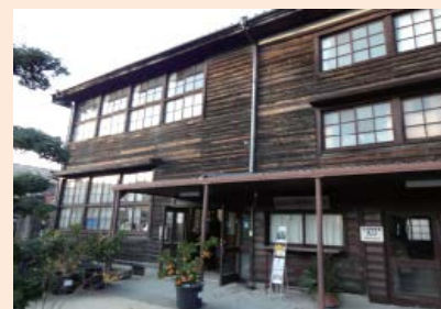
廃校・廃屋等改修交流施設 (秋津野ガルデン体験棟)
