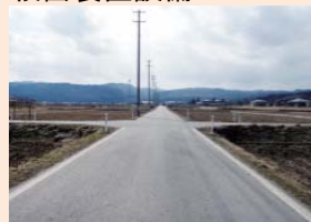
農業用道路の設備
