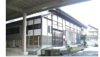
空き家の改修
