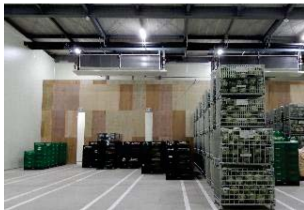
＜2019年7月竣工の冷蔵保管庫＞
