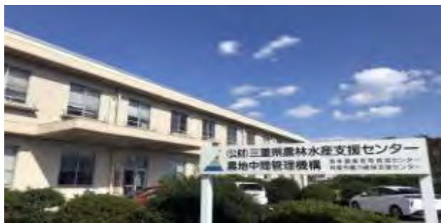
三重県農林水産支援センター外観
