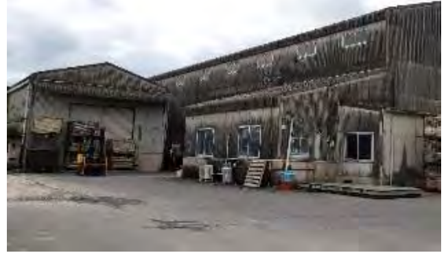
共同事業で活用予定のライスセンター
