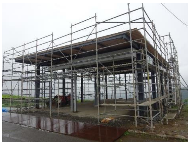
地域農家が共同で利用する集荷場を整備中の様子
