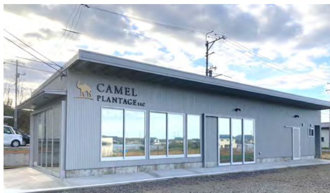
新設した作業場の外観
