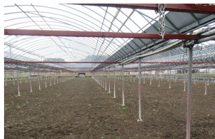
承継する農地と農業用ハウス（保安全管理中）
