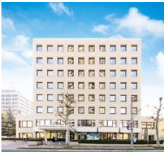
福島県自治会館
