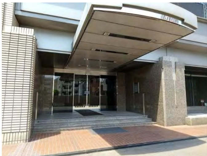
千葉県JA情報センタービル外観
