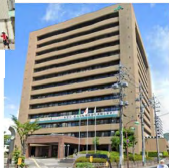
J A長野県ビル外観
