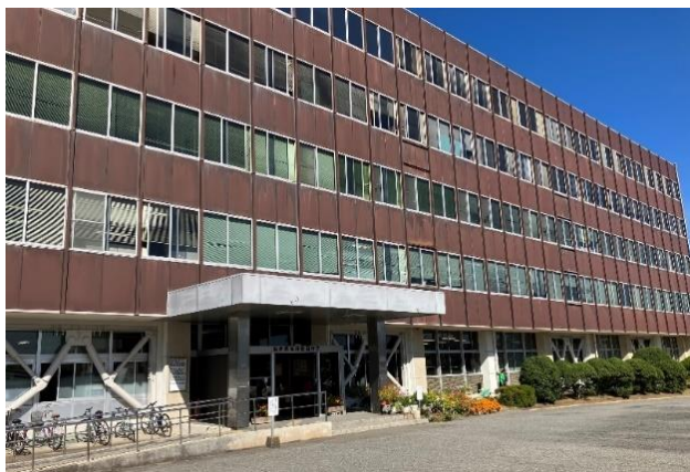
福井合同庁舎外観
