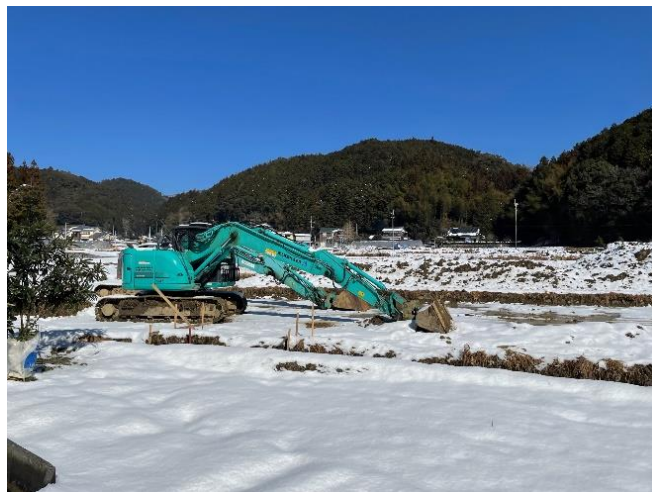
令和6年度に始まった基盤整備工事の様子
