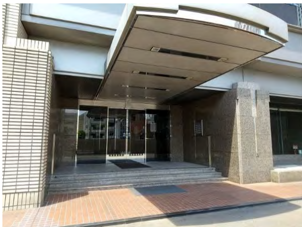
千葉県JA情報センタービル外観
