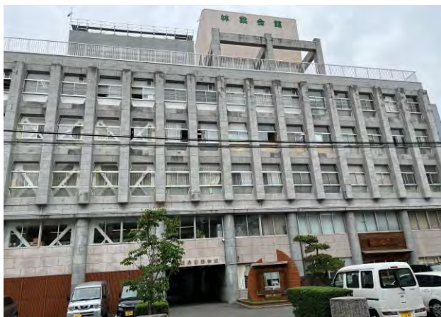
愛媛県林業会館の外観
