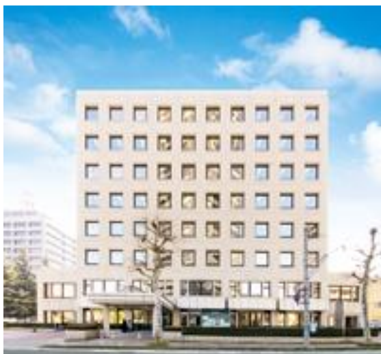
福島県自治会館
