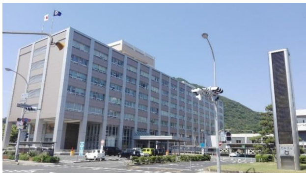
鳥取県庁本庁舎外観
