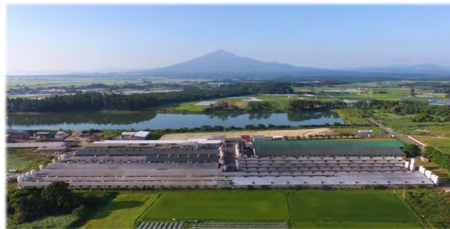
(株)木村牧場の肥育舎外観
