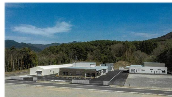
製粉工場の外観
