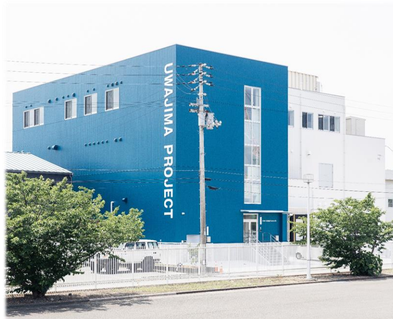
(株)宇和島プロジェクトの新社屋兼工場の外観
