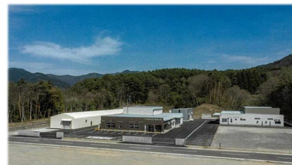
製粉工場の外観
