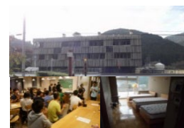
廃校を利用した交流施設
