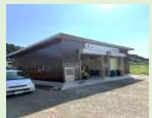
R7.3月に法人化した担い手の農業用倉庫
