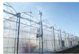
生産技術高度化施設 (低コスト耐候性ハウス)
