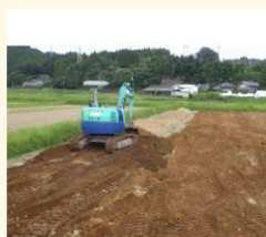
土層改良（客土）
