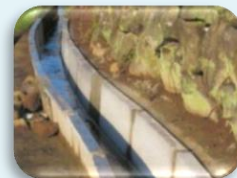
コンクリート水路の更新
