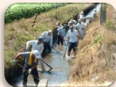
水路の泥上げ
