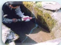
水路のひび割れ補修
