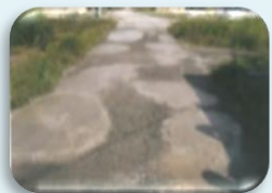
農道の窪みの補修
