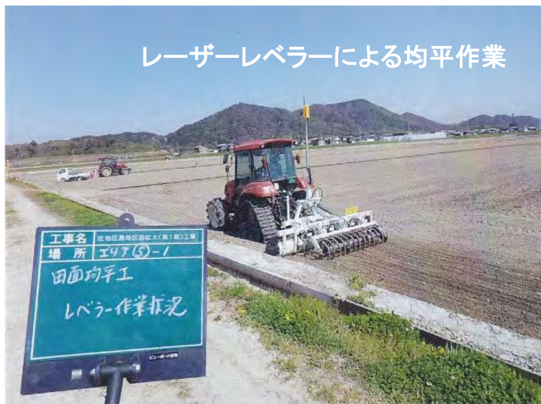
レーザーレベラーによる均平作業
