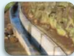
コンクリート水路の更新
