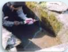
水路のひび割れ補修
