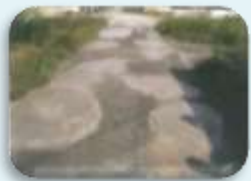
農道の窪みの補修
