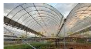
簡易雨よけ設備の設置
