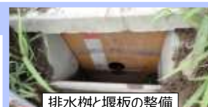
排水柵と堰板の整備
