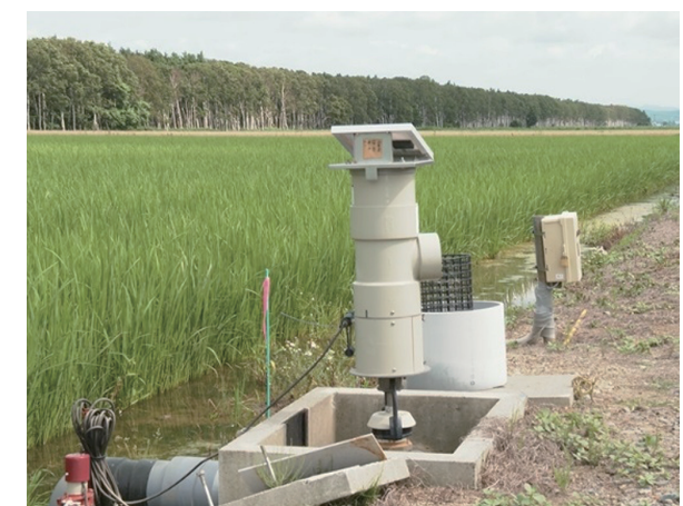
スマホやPCで状況がわかり、給排水のコントロールができるシステムの例
