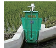
開水路で使用する自動給水装置。自動的にゲートを閉めて止水する。
