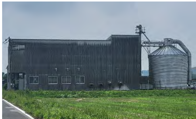
株式会社中川サンライズ乾燥調整施設
