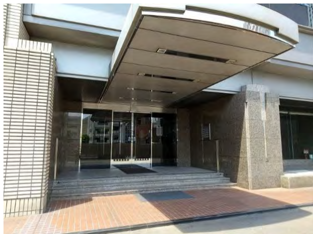
千葉県JA情報センタービル外観
